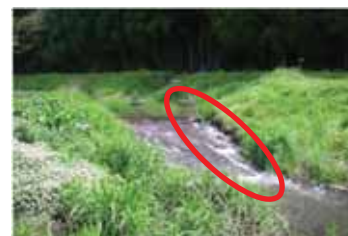
スロープ式落差工改良前
