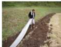
②遮水板設置状況
