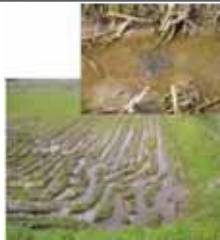
水田わだち状況
