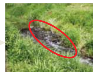
スロープ式落差工改良後(玉石の設置)
