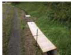
③橋設置状況
