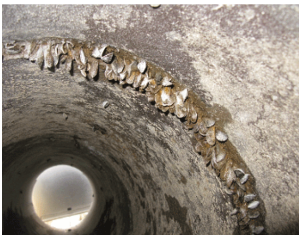
図20 排泥工における固着状況
