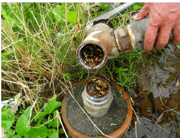
図21 給水栓の閉塞及びストレーナーにおける目詰まり状況（死貝）
