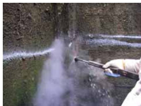
高圧温水機による噴射作業
