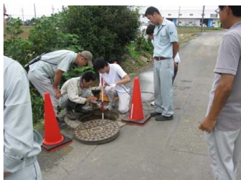
図 31 工業用内視鏡による調査
