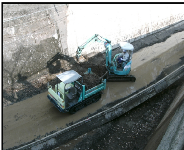
図 47 樹脂製アタッチメントとゴム製クローラーを装着した重機による駆除
