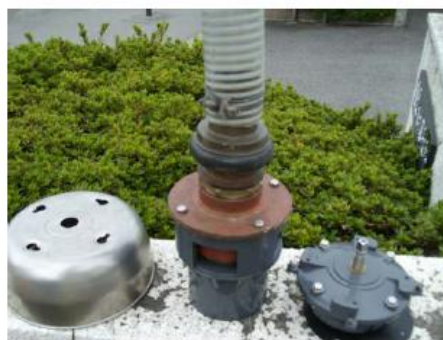
図 65 一筆用給水栓（写真左）一筆用給水栓への接続状況（写真右）
