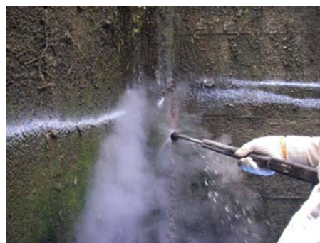
高圧温水機による噴射作業
