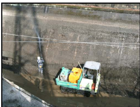
図 48 重機の侵入が困難な場所等に適用可能な高圧放水機
