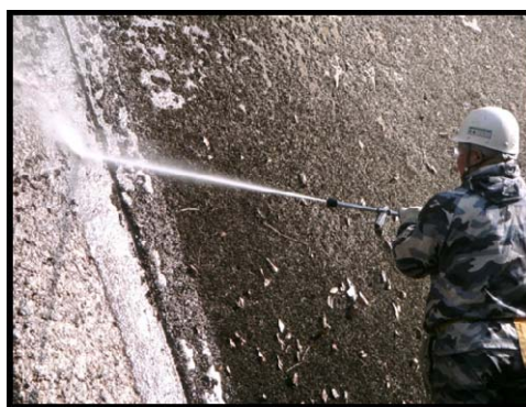
図 48 重機の侵入が困難な場所等に適用可能な高圧放水機
