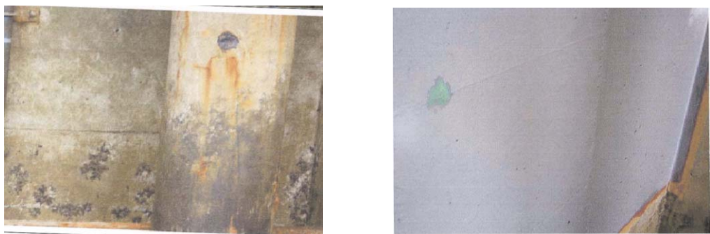
図 61 固着防止資材施工（左が塗装前、右が塗装後）
