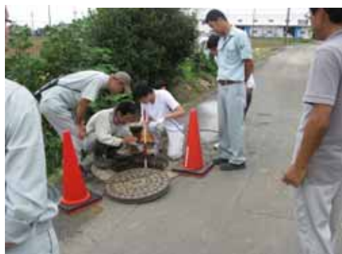
図 31 工業用内視鏡による調査
