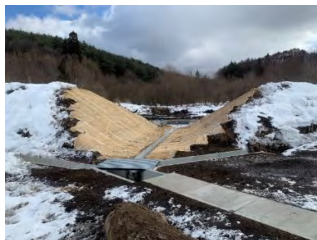
廃止工事写真（施工後）
