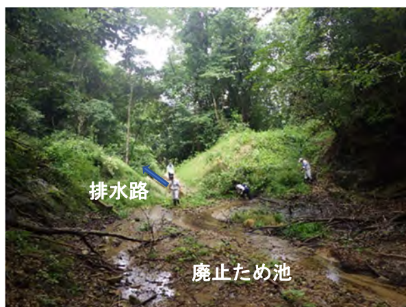
廃止から1年6ヶ月後のため池跡地（山口県）
