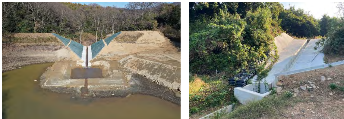
図 2-2 堤体開削の例
