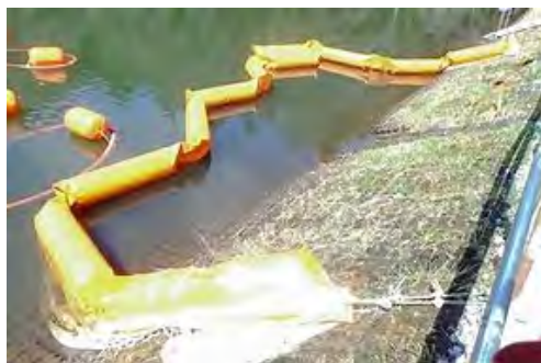
汚濁防止膜の設置
