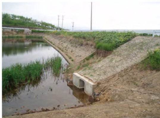
図 2-3 暗渠工法による廃止事例
