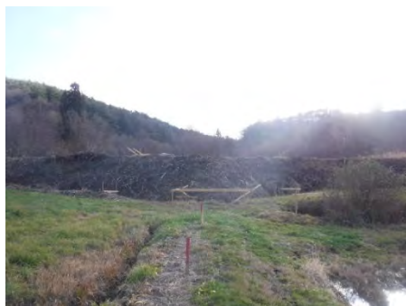
廃止工事写真（施工前）
