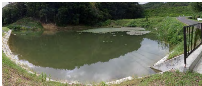
ため池全景（c2 池）*2
