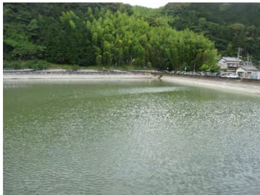
ため池写真（水抜き作業前）
