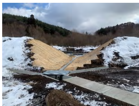
廃止工事写真（施工後）
