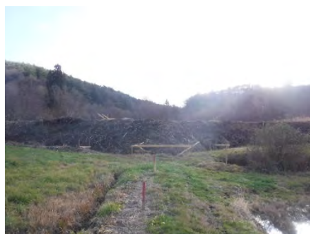
廃止工事写真（施工前）
