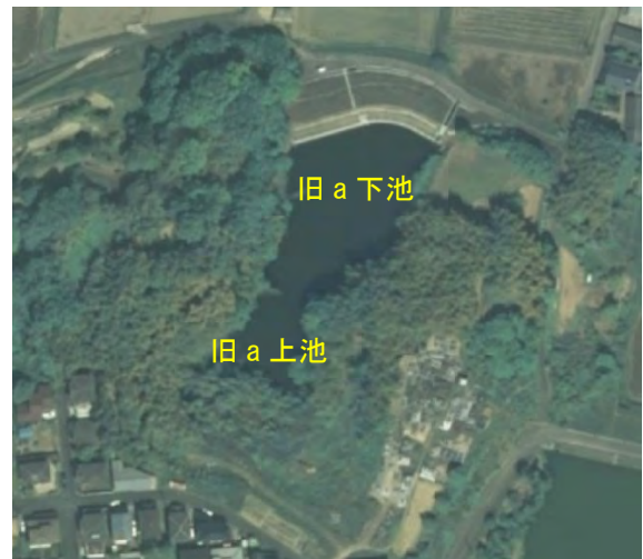
図 5-1 平成 21 年撮影（工事後）航空写真（出典：国土地理院）
