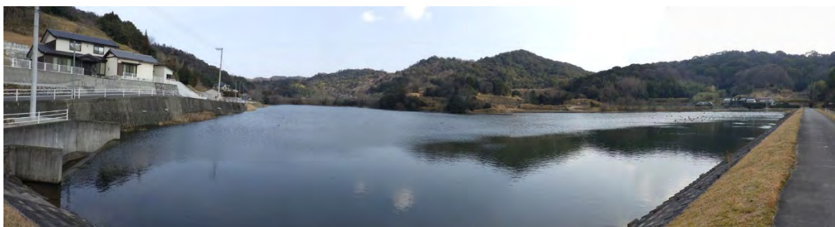
b1 池全景（令和 4 年 2 月撮影）
