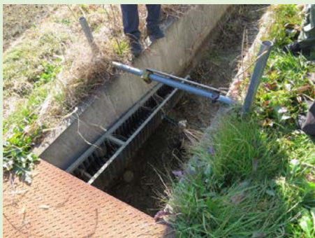
設置された魚道
