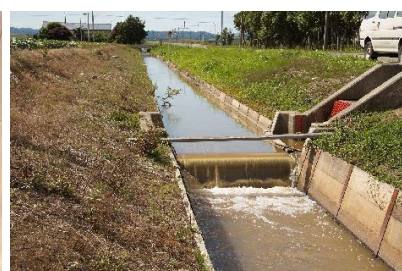
取水ゲートにおける落差
