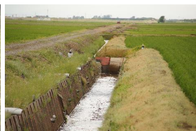
水田と排水路との落差
