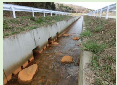
魚巢ブロックの設置
