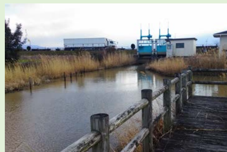
保全施設（浄化池）
