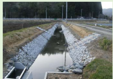
環境保全施設（V型水路）
