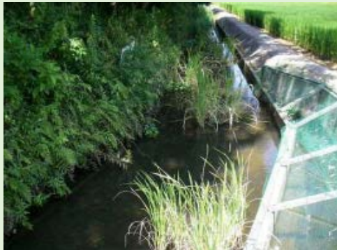
生態系配慮水路
