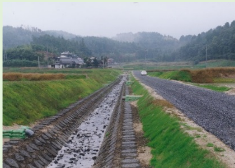
排水路の様子
