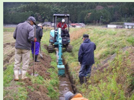
水路の泥上げ
