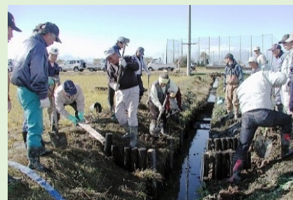
住民による魚道設置
