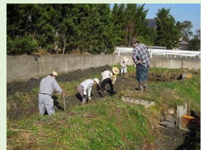
水路の維持管理
