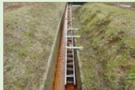
設置した魚道
