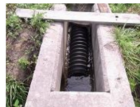
コルゲート管による落差解消
