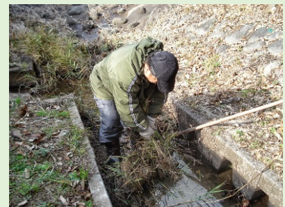
水路の維持管理
