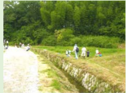
石積水路の様子
