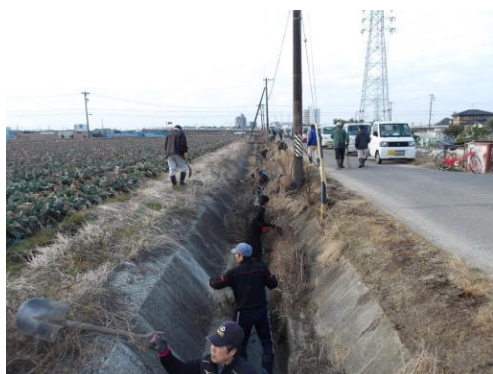
泥上げの作業風景
