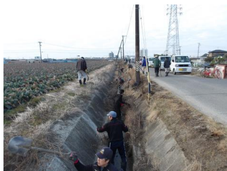
泥上げの作業風景
