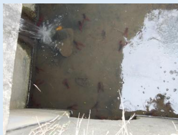
落水後の集水柵の状況
