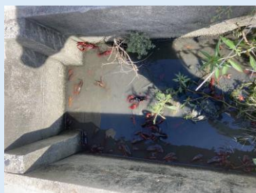
落水後の排水路の状況
