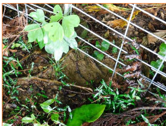
柵の下部に隙間あり
