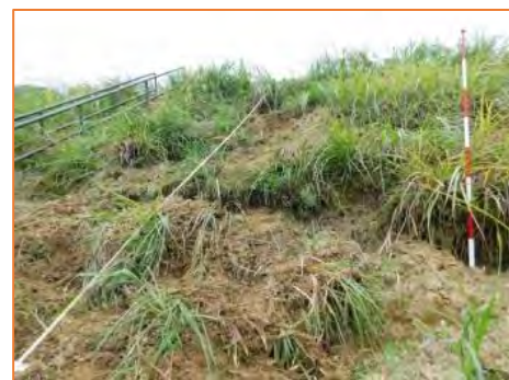
イノシシによるため池堤体の掘り返し被害の例
