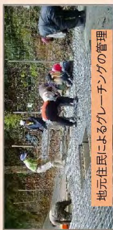
スチール製格子構造 設置幅 7.0m、奥行 4.3m、深さ 0.30m
