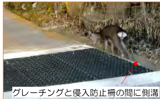
グレーチングの奥行きが 1.6m グレーチングを跳躍して通過 （奥行きが不足）
