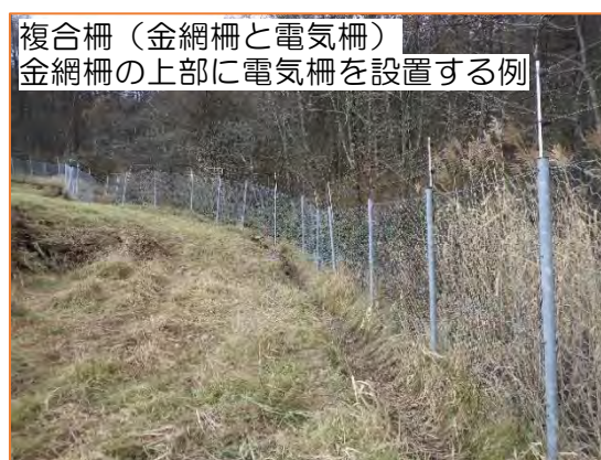
侵入防止柵の例
