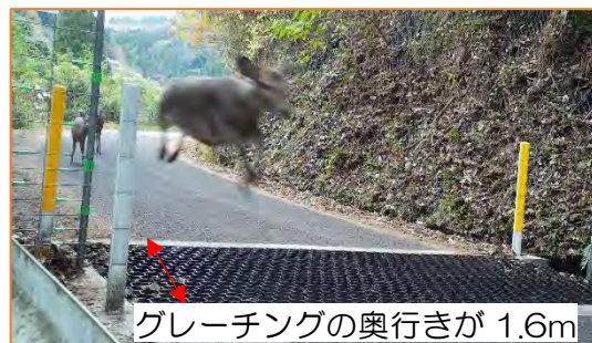
グレーチングの奥行きが 1.6m グレーチングを跳躍して通過 （奥行きが不足）
