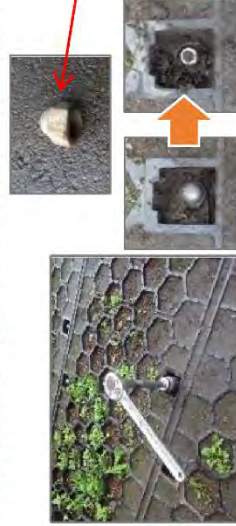
レンチでガードナットを取り外す
