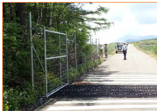
グレーチングと侵入防止柵との隙間を埋める工夫の例
