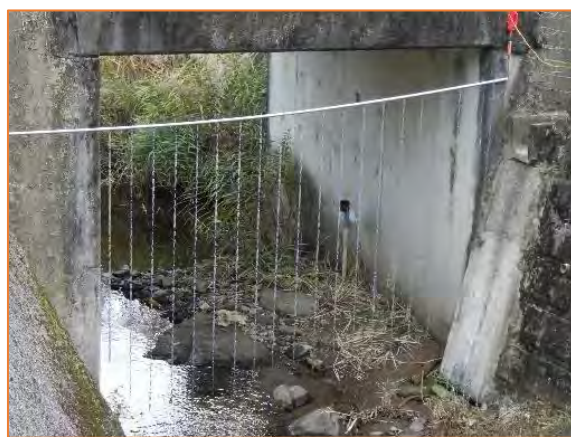
水路に通電性のれんを設置
