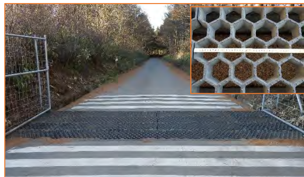
スチール製ハニカム構造のグレーチング例
