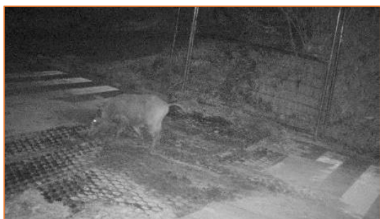
グレーチングに堆積した土砂の上を通過 （土砂堆積による機能阻害）
