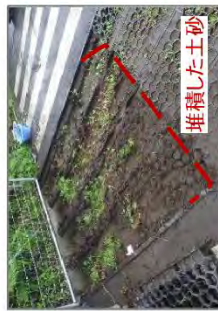
グレーチングを取り外した状態
