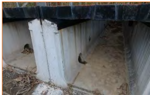
グレーチングと侵入防止柵との隙間を埋める工夫の例
