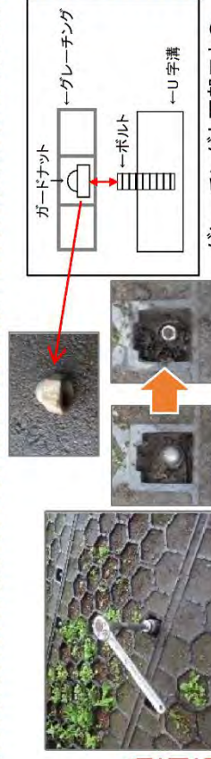
レンチでガードナットを取り外す
