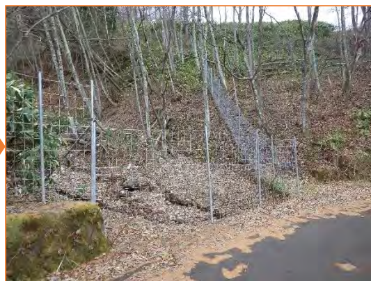
修繕された侵入防止柵
