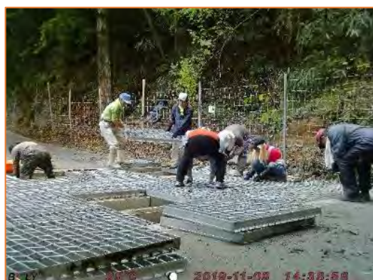
グレーチングの維持管理作業（土砂撤去）の例（左：重機使用、右：人力）
