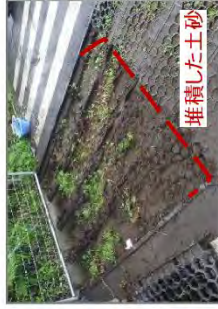
グレーチングを取り外した状態
