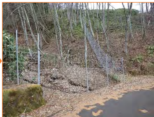
修繕された侵入防止柵
