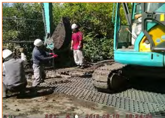
グレーチングの維持管理作業（土砂撤去）の例（左：重機使用、右：人力）
