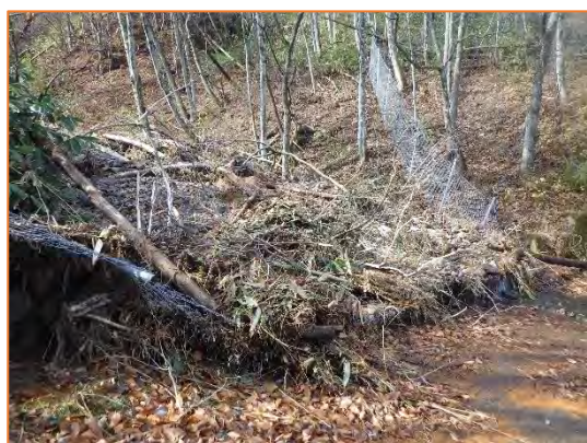
出水により倒壊した侵入防止柵
