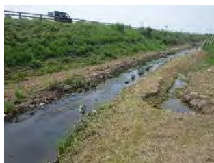
環境配慮護岸②
