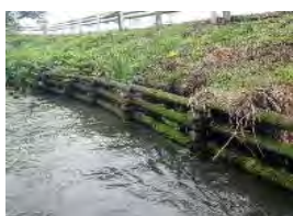
井桁沈床工 (A地区)
