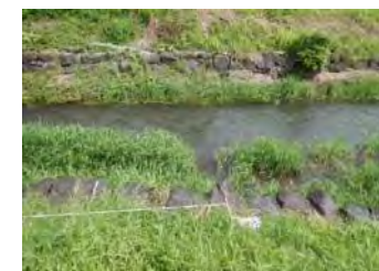
配慮護岸（二面装工区間）
