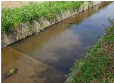
深み工(F地区)
