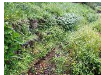
一部のブロックが土砂に埋没
