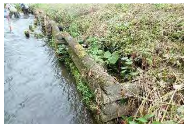
井桁沈床工②
