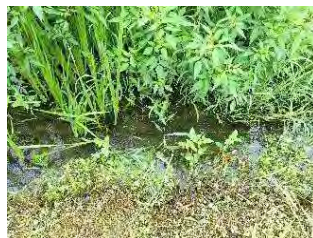
水路内の抽水植物の繁茂
