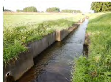
深み工（幅広区間）
