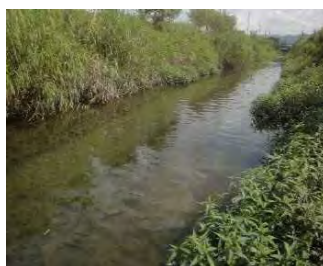
環境配慮護岸・深み②
