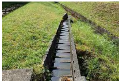
水路魚道①
