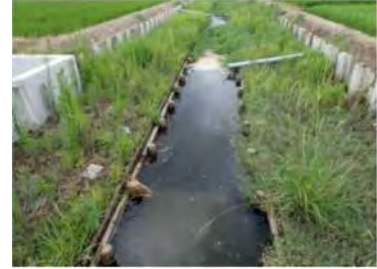
ビオトープ(湿地区間)
