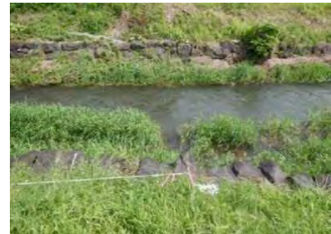
配慮護岸(二面装工区間)
