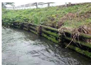
井桁沈床工 (A 地区)
