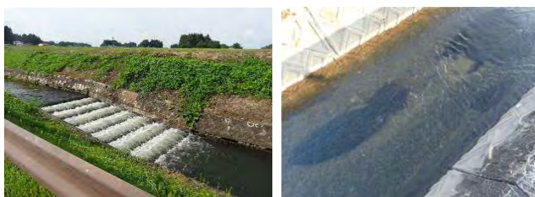
二面張り水路 (B 地区)
