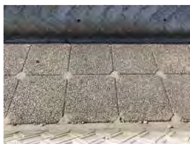
ポーラスコンクリート
