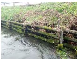
井桁沈床工①
