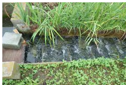
水路魚道(千鳥 X 型)の上流部
