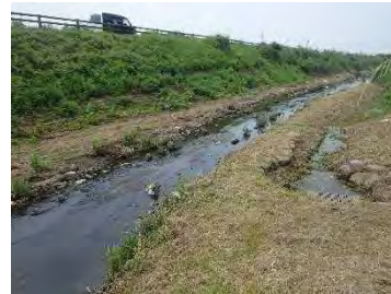
環境配慮護岸②
