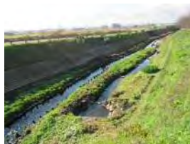
配慮護岸 (I地区)
