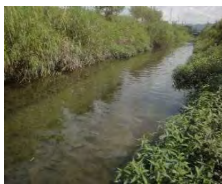
環境配慮護岸・深み②
