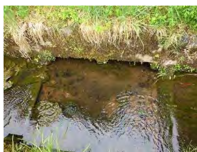
水路の深みと魚巣ブロック
