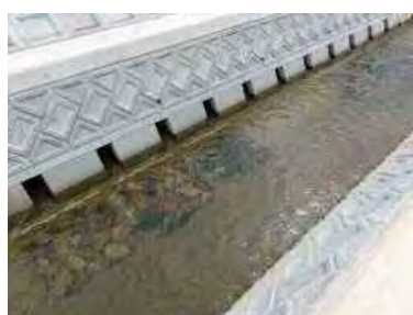
玉石詰め工+魚巣ブロック
