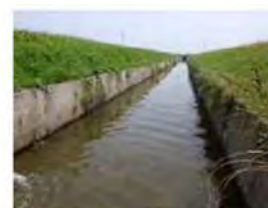
図7 St. 16：排水路B直線区間
