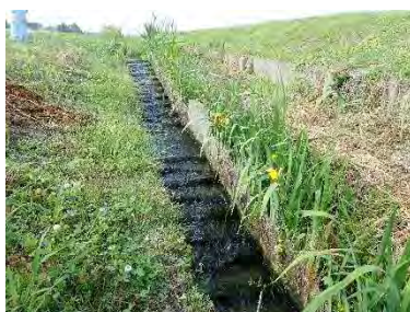
水路魚道 (A 地区)
