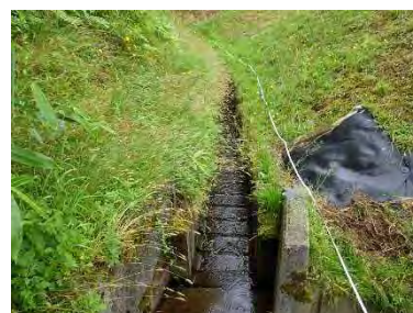
水路魚道 (J 地区)
