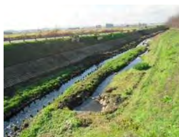
配慮護岸 (I 地区)
