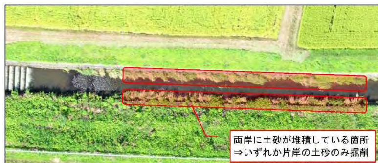
【実証区間の二面装工区間】
