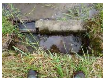
堰板が設置された呑み口
