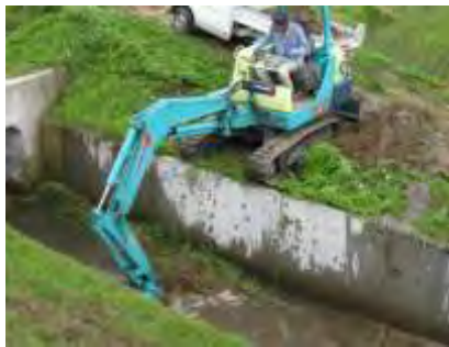
重機（バックホー）での土砂引き揚げ作業
