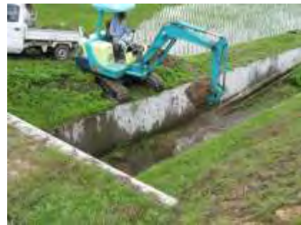
重機（バックホー）での土砂引き揚げ作業
