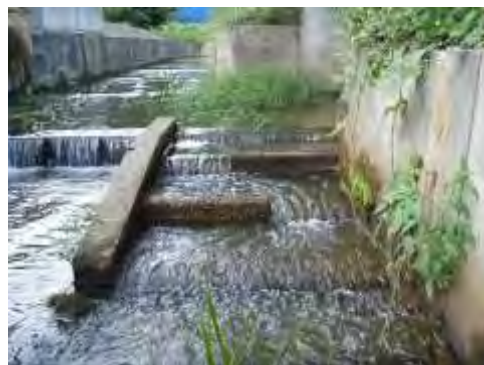
水路魚道の維持管理作業後
