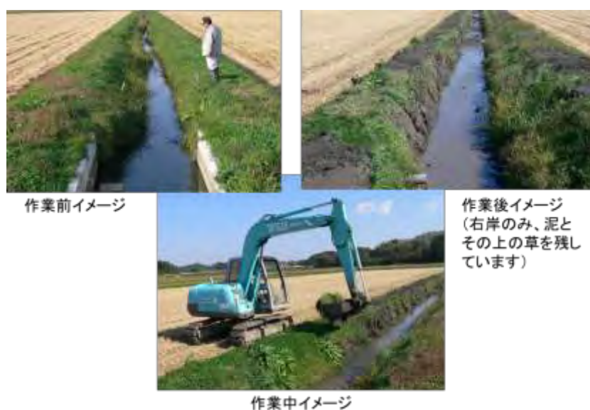
図3-3 泥上げのローテーション作業のイメージ
