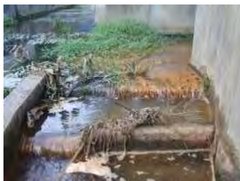
水路魚道の維持管理作業前
