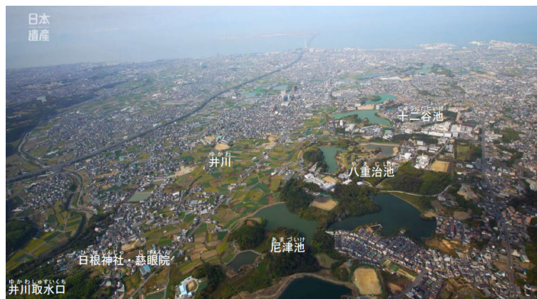
現在の井川用水遠景 (航空写真)
