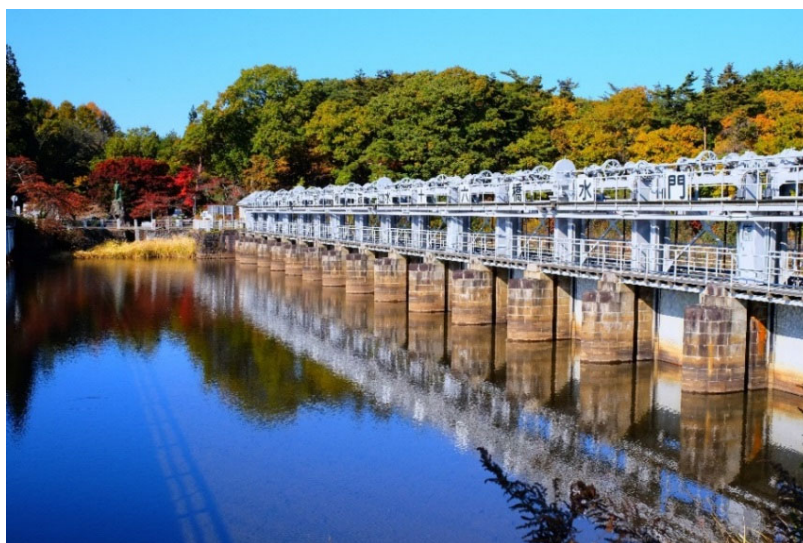
現在の十六橋水門
