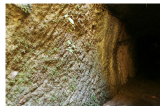
ノミの跡が残る藤ヶ谷水路 トンネル内部（広瀬井路）
