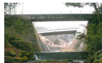
大久保沢「掛樋」 (手前の橋)
