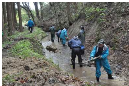
穴尻から田んぼまで続く開水路の土砂払い作業
