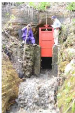
「狭間(さま)」隧道の横穴 隧道の土砂が水力で排出
