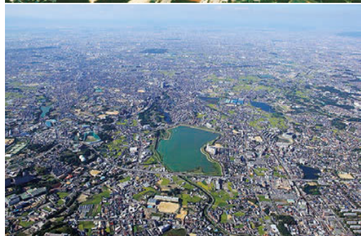
上：平成の改修前の狭山池 (1998年) 下：平成の改修後の狭山池 (2000年)
