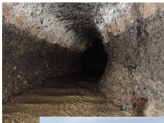
宝永隧道内部
