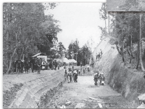
米増地内の 上江用水改修工事の様子 1915 年（大正 4 年）
