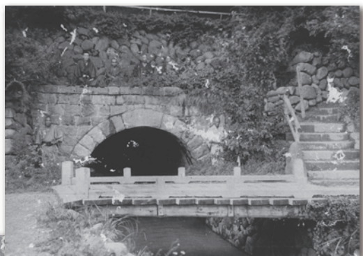
1931 年頃の川上隧道
