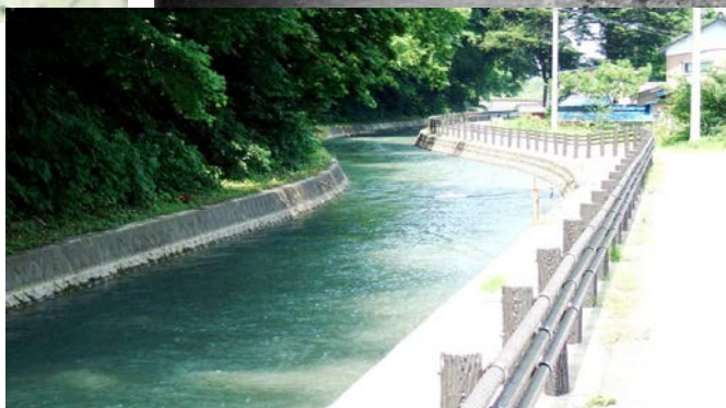
昭和初期（上）と現在（下）の北楯大堰
