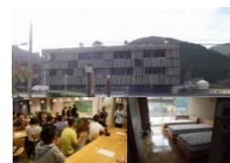
廃校を利用した交流施設
