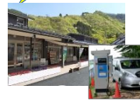
EV車等への給電設備
