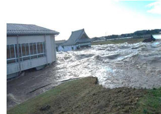
令和元年度台風19号被害
