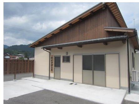
＜処理施設の外観＞
